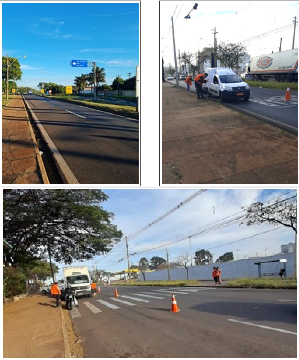
Figura 2.6: Disposição e localização da equipe de pesquisa do ponto LC05 - Via de acesso Eng. Ivo Najm (próximo à Cutrale) no período da manhã e Av. Padre José de Anchieta (defronte CPFL Atende) no período da tarde
